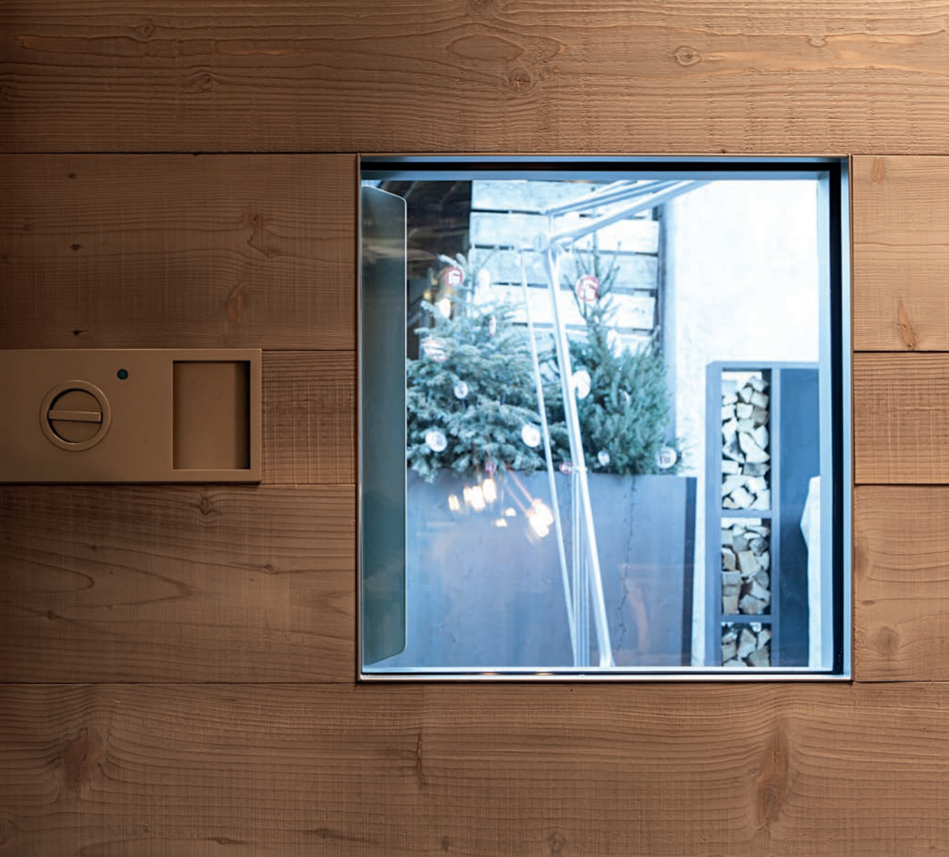
Interno: Rivestimento personalizzato realizzato dal cliente Inserimenti vetro blindato trasparente a disegno, accessori e profili finitura bronzo chiaro, Serratura con sistema elettronico motorizzato ArcKey
